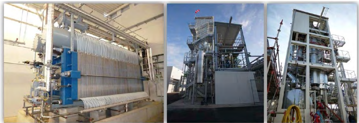
Abbildung 4: Elektrolyseure (3 x 2 MW) & Methanisierungseinheit
